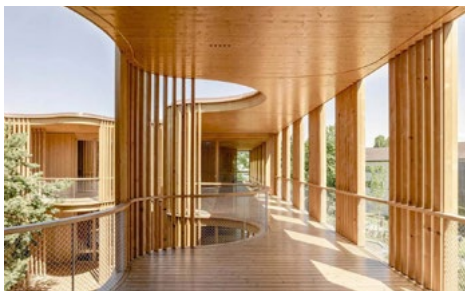
Kindergarten in Ittigen von Büro B Architekten. Foto: Alexander Gempeler
